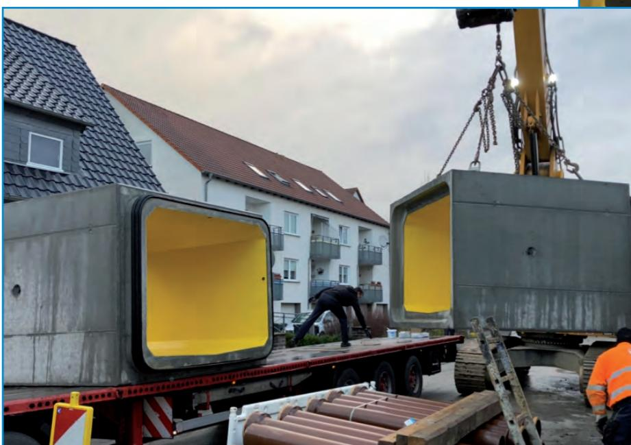
Die **Perfect Box** ist ein neues, innovatives Stahlbeton-Rahmenprofil mit zwei Trockenwetterrinnen als V-Sohle. Das Rahmenprofil ermöglicht den Einbau in vier verschiedenen Varianten.
