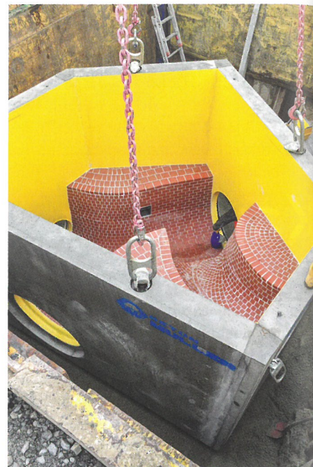
Versetzen des Fertigteilbauwerkes in die Baugrube.
