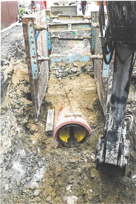
Auf dem Bild gut zu erkennen: der schwierige, felsige Baugrund.
