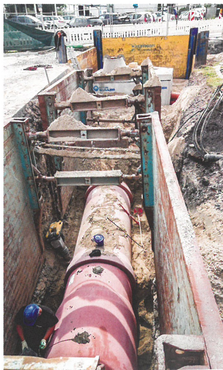
Eine 80 Meter lange Haltung wurde mit Perfect Pipe-Rohren DN 1000 erneuert.
