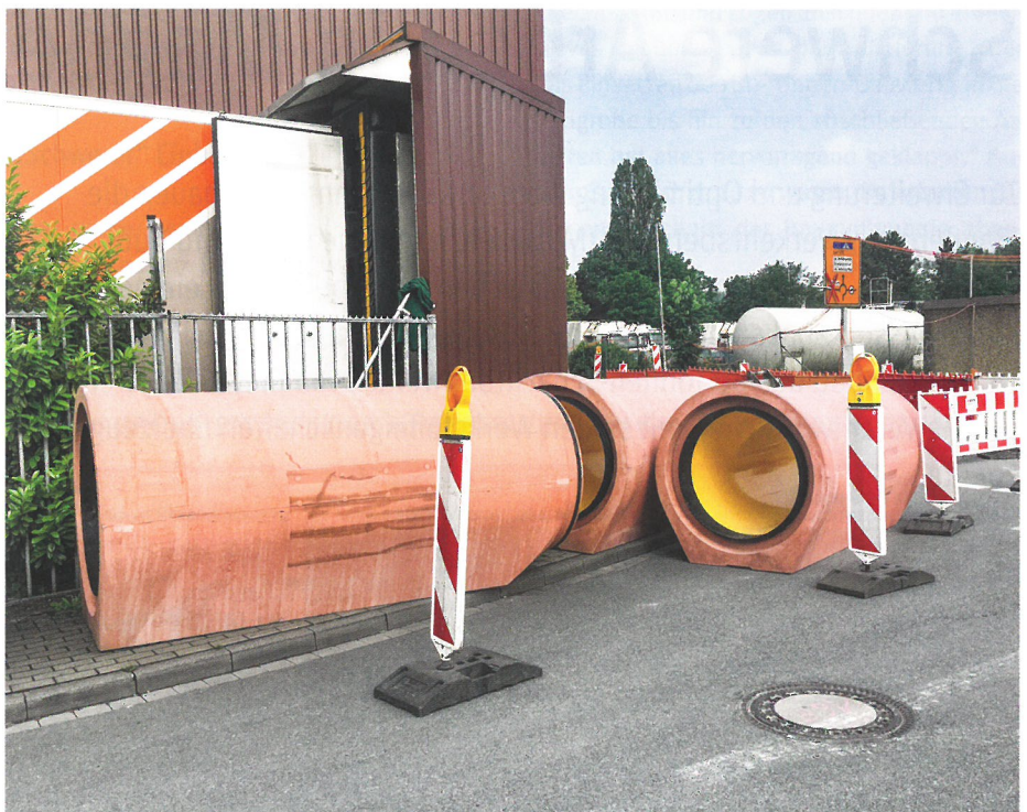
Die Herstellung des Planums für das Rohraufleger erfordert wegen der breiten Auflagerfläche des Fußrohres etwas mehr Sorgfalt, dafür entfällt die kritische und aufwändige Zwickelverdichtung. | Fotos: Beton Müller
