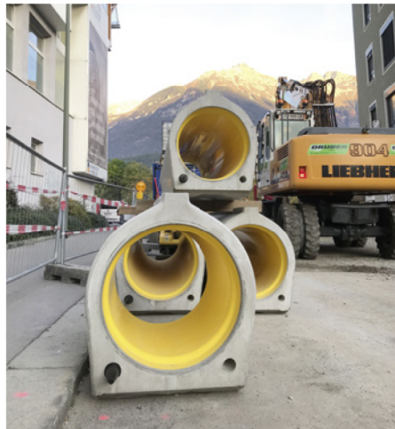
Die breite Auflagefläche des Fußrohres gehört zu den Vorteilen von Perfect Pipe.
