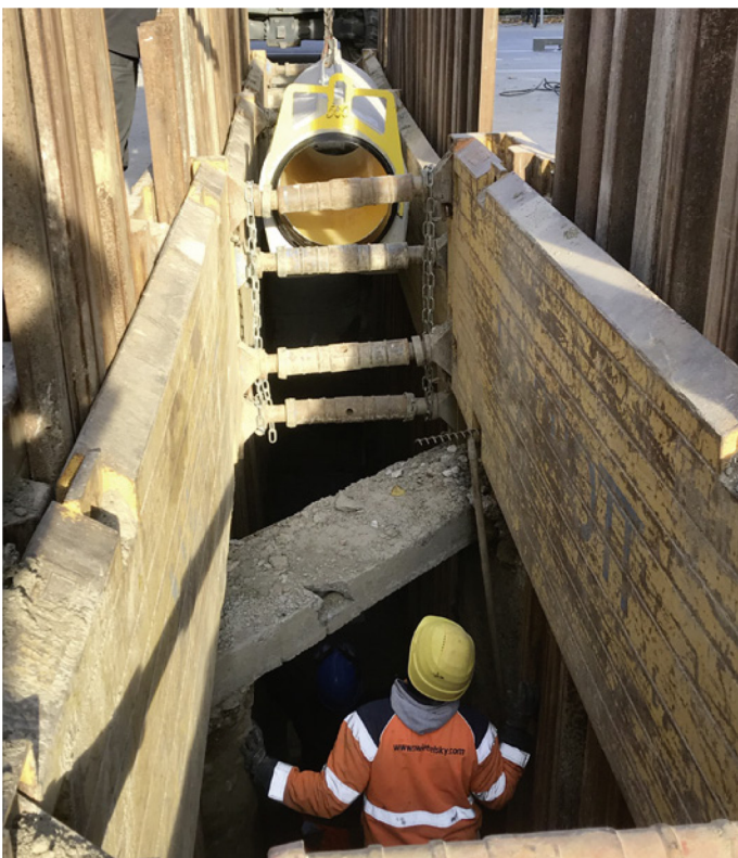
Die Verlegefreundlichkeit der Rohre bestätigt sich auch auf der Baustelle in Innsbruck.
