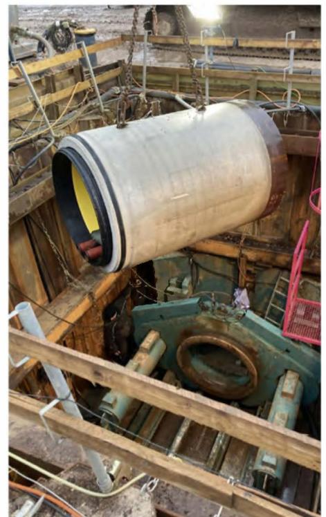
Perfect Jacking Pipe-Rohre sind mit zwei Kugelkopfankeim in Rohrscheitel versehen und konnten mit Kugelkopfabhebern sicher abgeladen und in die Startgrube abgelassen werden. | Foto: Müller Beton
