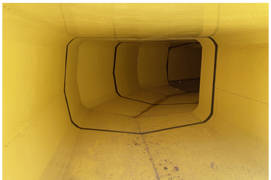
Blick in den fertig verlegten Sammler
