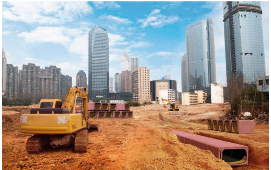
Beispiel liegende Verlegung: Gegenüber einem runden Rohr DN 1400 reduziert sich die Bauhöhe der Perfect Box 1400 um 30 Zentimeter.
