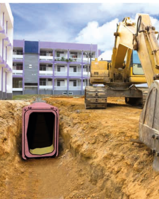
Beispiel stehende Verlegung: Hochkant eingebaut lässt sich ein großer Abflussquerschnitt in einem schmalen Graben realisieren. | Abbildungen: Beton Müller.
